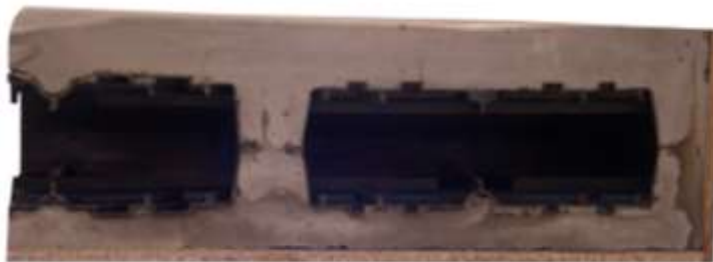
شکل ۸- مقطع سقف یوبوت دوبل
