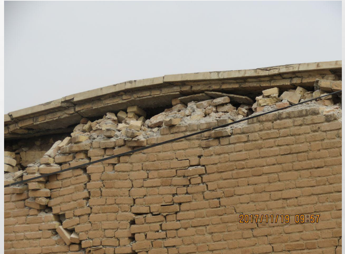
عدم پیوستگی کافی سقف و دیوار
